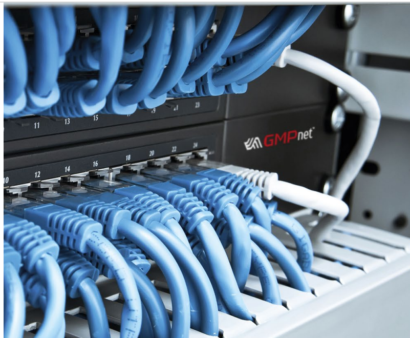
Patch panel 19" 1U 24xRJ45 kat.5e UTP NR KATALOGOWY: CU.PP.00018
